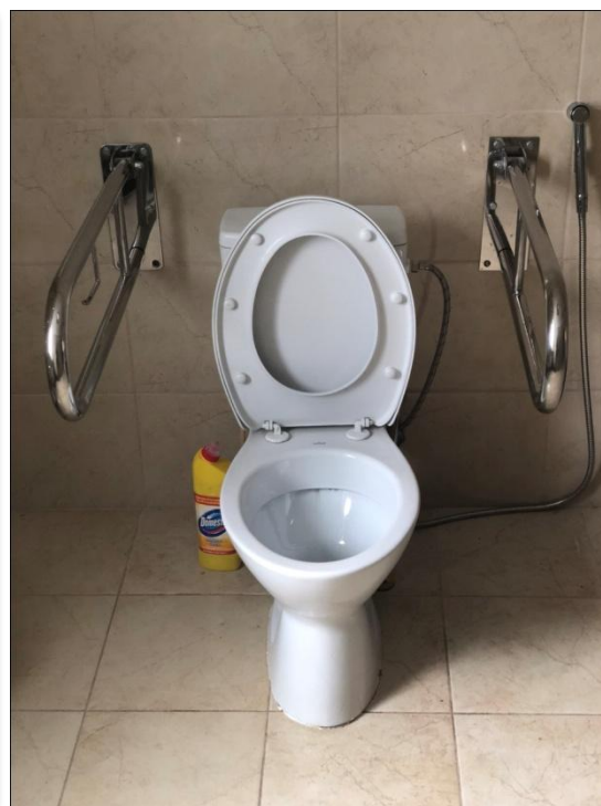
Кімната вбиральні, облаштована спеціальними поручнями
