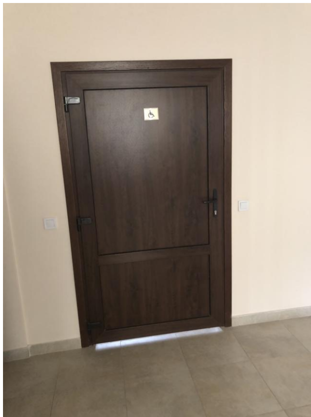
Вхід у вбиральню для маломобільних груп населення (з шириною дверей більше 105 см)
